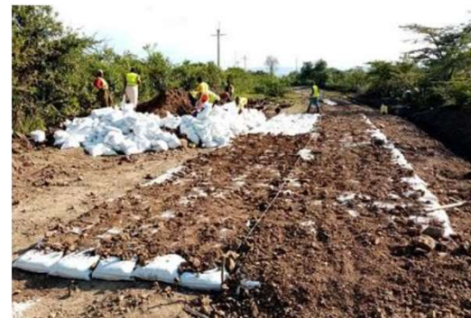
土嚢工法による整備
